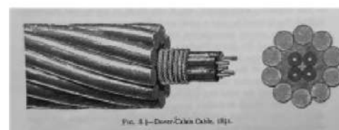
圖 1.21 成功放下英倫海峽的海底電報纜
