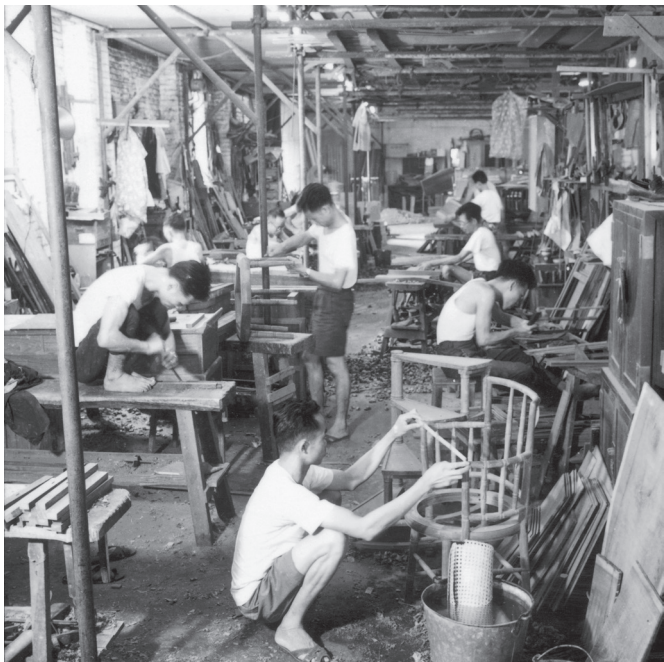
■ 大角咀是一九五〇年代木工家具店和剝木廠的集中地之一。這張照片展示了當年家具工場的工作情況，年僅十六至十八歲的學徒們正使用傳統木工工具。工場不僅是他們學習與工作的地方，也承載著他們的生活與睡眠。（圖片來源：香港政府新聞處圖片資料庫）
