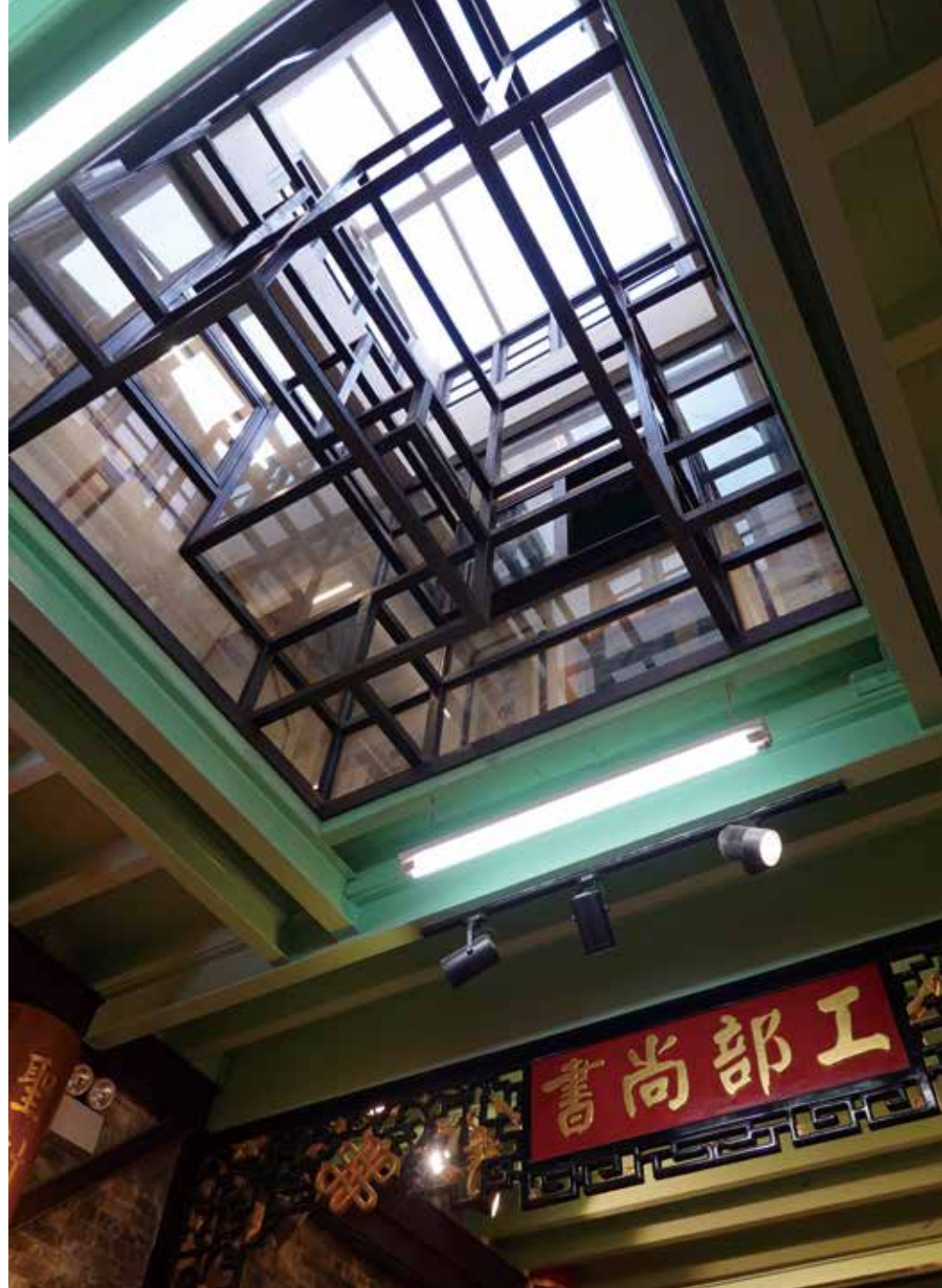
以魯班鎖為設計靈感的光井結構
