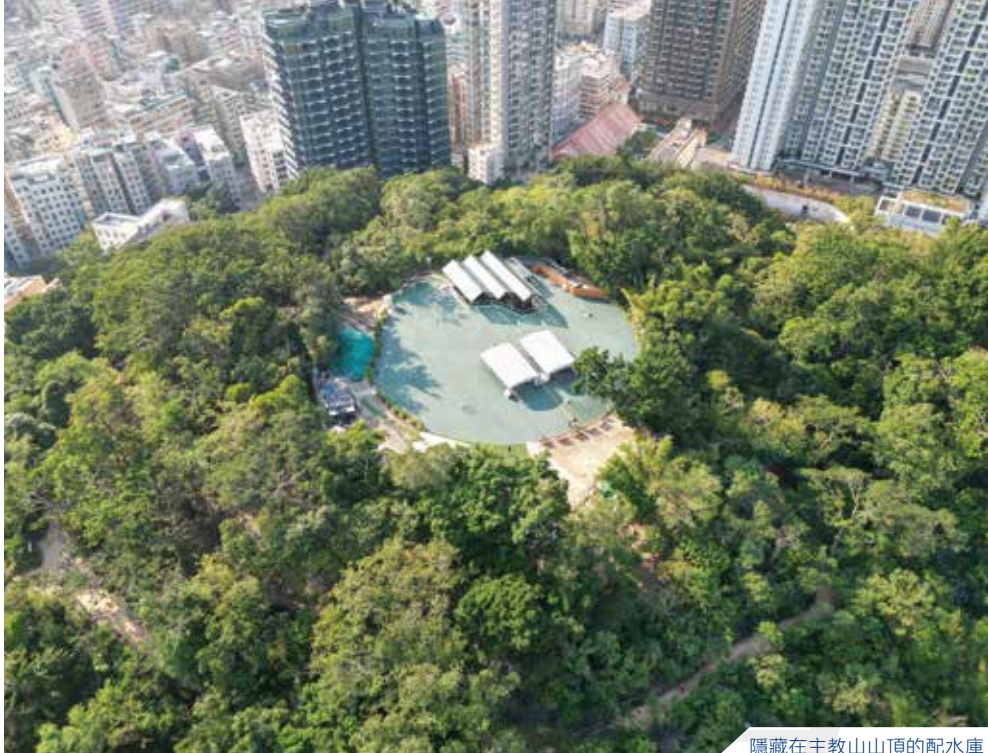
隱藏在主教山山頂的配水庫
