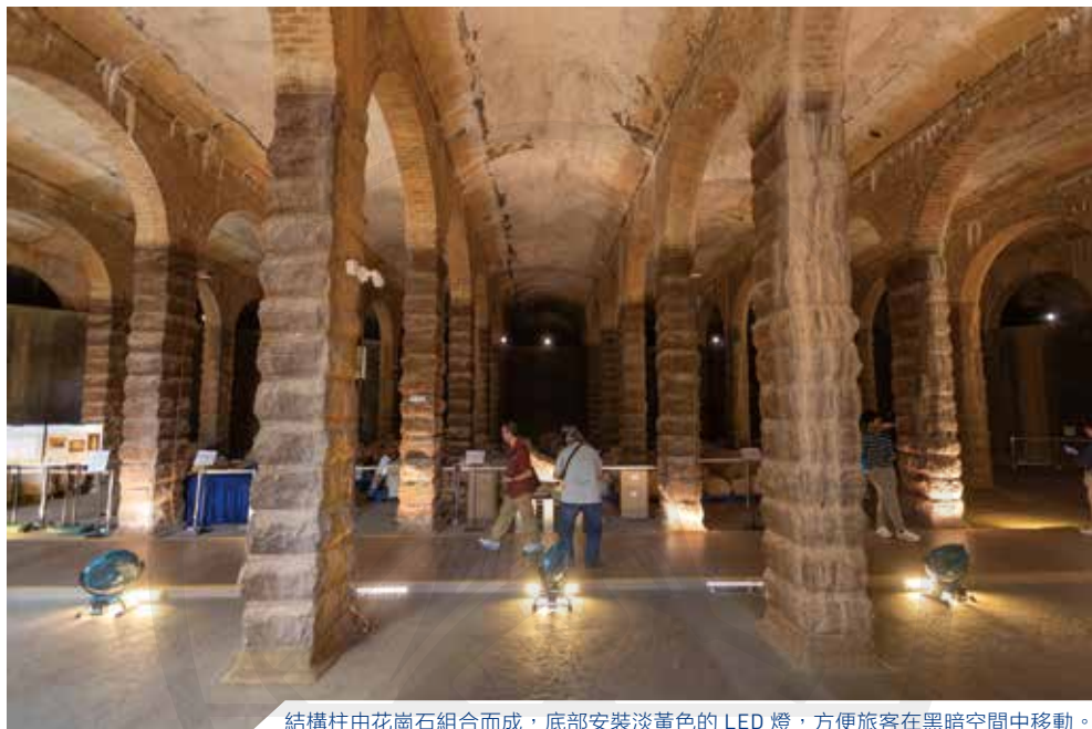
結構柱由花崗石組合而成，底部安裝淡黃色的 LED 燈，方便旅客在黑暗空間中移動。
